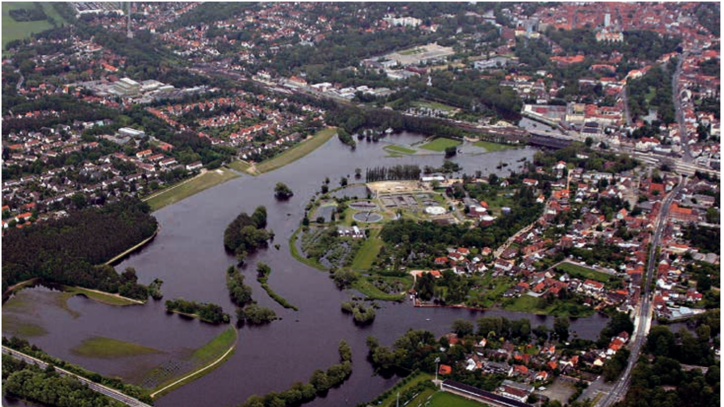
Celle beim Hochwasser im Juni 2013: In der Bildmitte ist die Kläranlage zu erkennen, links davon ein Teil der 2012 fertiggestellten Deiche.
