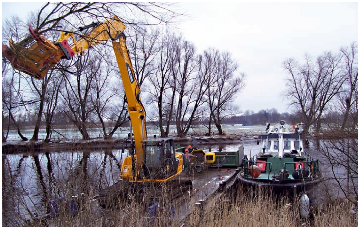
Ein Gespann, das sich bewährt hat: Der Schlepper „Seehund“ sowie der Ponton mit Hydraulikbagger bilden das Rückgrat für die Unterhaltungsarbeiten an der Oste.
