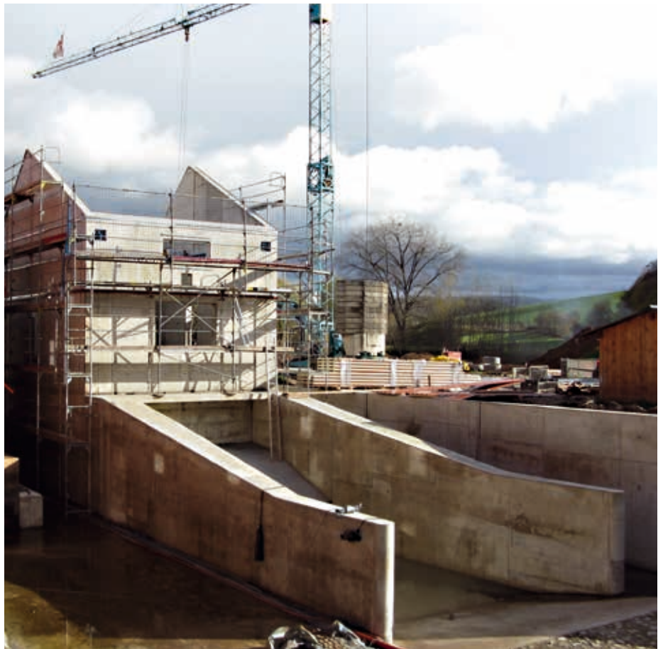
Strom aus Wasserkraft noch besser nutzen: Der NLWKN hat in Hedemünden den Einbau einer zweiten Turbine genehmigt.
