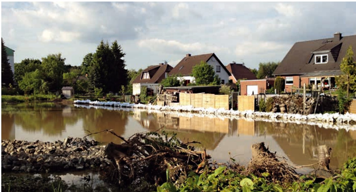
Die Nette bei Holle trat im Mai 2013 kräftig über die Ufer – die Schäden hielten sich dennoch in Grenzen.
