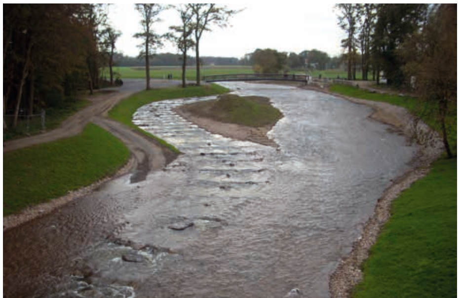
Nach rund siebenmonatiger Bauzeit wurde im November 2013 die Sohlgleite in Quakenbrück offiziell in Betrieb genommen, das alte Schützenhofwehr wurde abgerissen.
