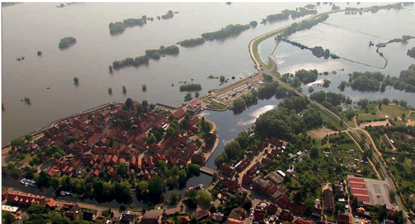
Die Hochwasserschutzanlagen in Hitzacker haben sich bewährt, die Stadt blieb 2013 trocken.
