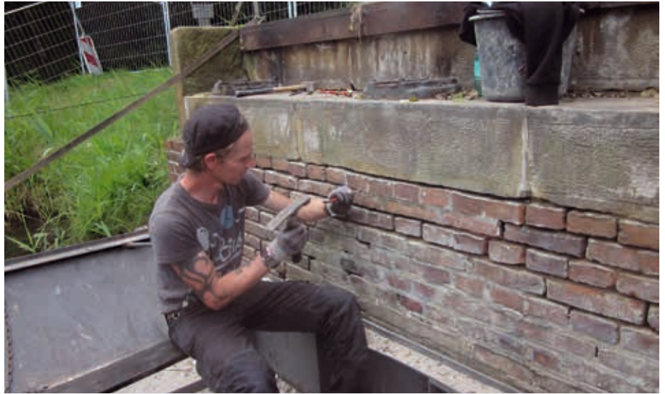
Die Sanierung der denkmalgeschützten Brücke Lübberink in der Grafschaft Bentheim haben die Mitarbeiter des NLWKN selbst übernommen.
