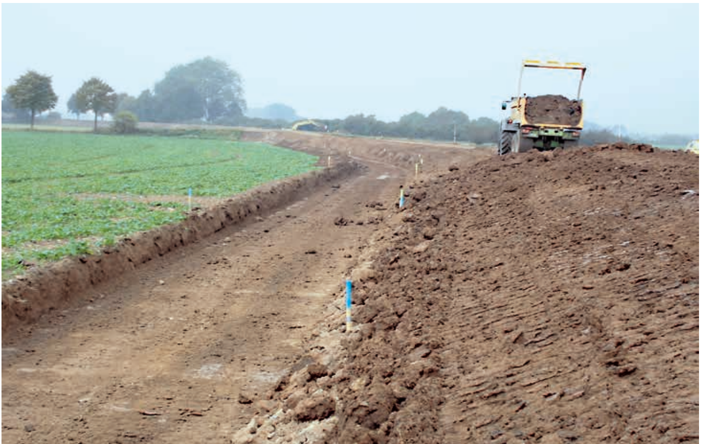
Deichbau in Verden an der Aller: Im Verbandsgebiet des Stedorfer Deichverbandes wird in den Ortsteilen Groß- und Klein Hutbergen der Deich verstärkt (Foto) und vor dem Schöpfwerk Hutbergen eine Stahlbetonbrücke gebaut. Damit ist an der neuen Deichlinie jetzt auch die Möglichkeit einer durchgängigen Deichverteidigung gegeben.
