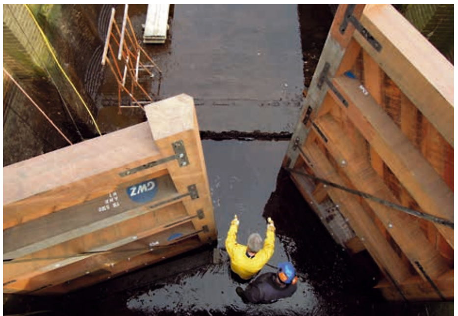
Die selbst gebauten Schleusentore aus Holz werden passgenau eingesetzt. Dieses Foto entstand in einer der Schleuse im Nordgeorgsfehnekanal.
